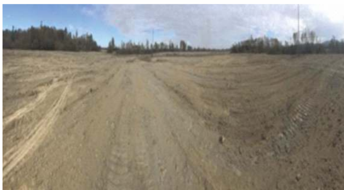
Odlagalište prije i poslije sanacije
